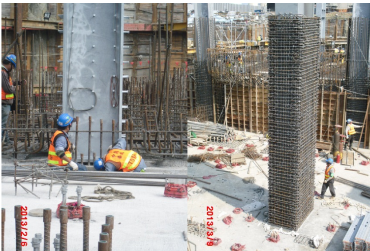
圖 1 鋼柱埋入柱墩施工
