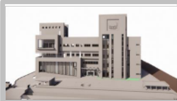
生技廠機電工程 建築類型： 生計廠 特色： 執行施工查核
