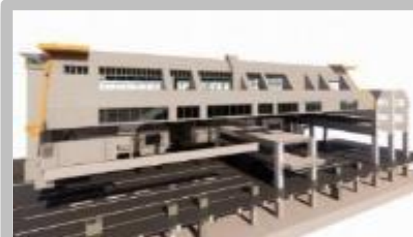
桃園機場第二航廈擴建 機電工程 建築類型： 航空站 特色： 執行施工查核
