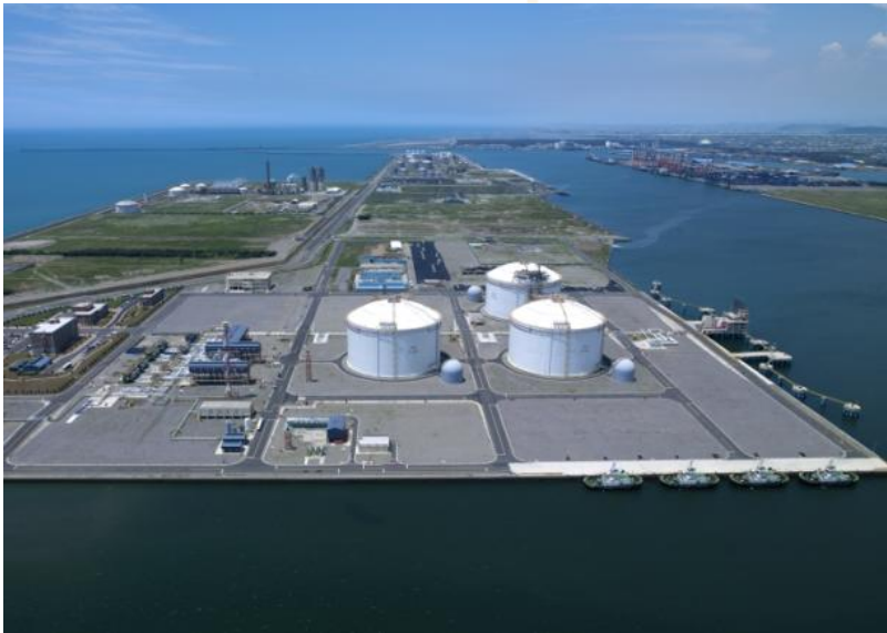
台灣 台中LNG接收站
