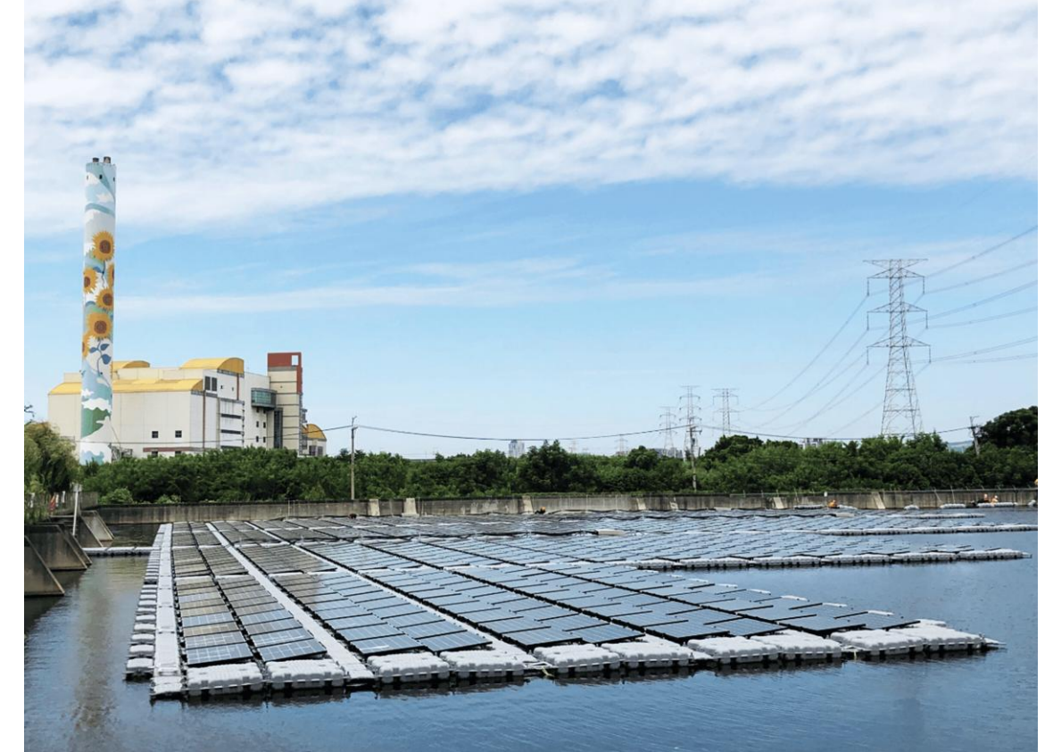
高鐵烏日滯洪池 /0.3 MWp
