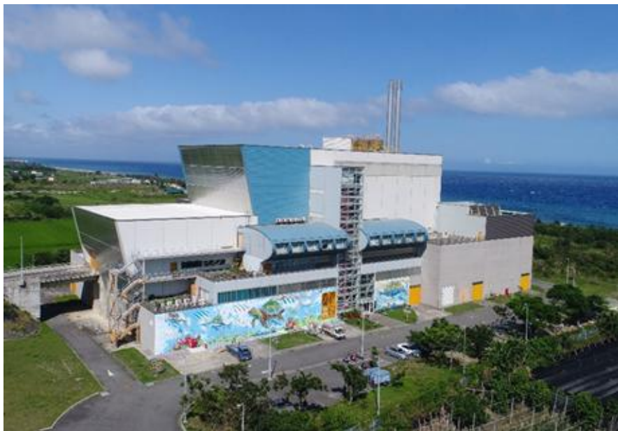
臺東垃圾焚化廠
