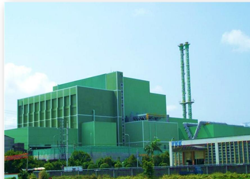
桃園市南區BOO垃圾焚化發電廠
