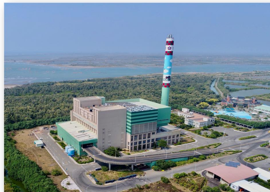
臺南市城西垃圾焚化廠
