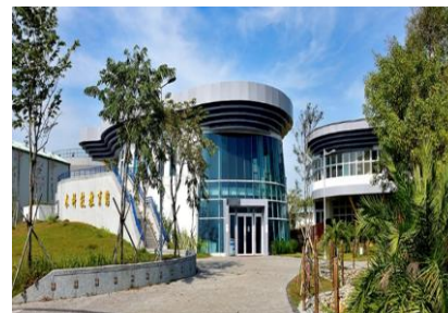
高雄鳳山溪再 生水廠
