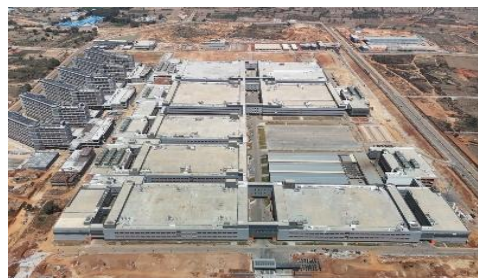
印度電子組裝廠 新建工程
