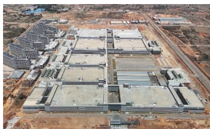
印度電子組裝廠新建工程
