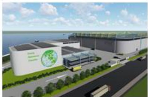
彰濱低碳循環再利用 暨處置中心
