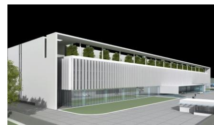
高雄和發園區鋰電池廠房新建工程案
