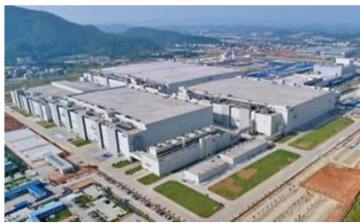
廣州TFT-LCD面板廠房無塵室新建工程案
