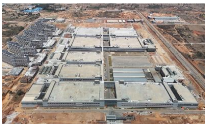
印度電子組裝廠新建工程
