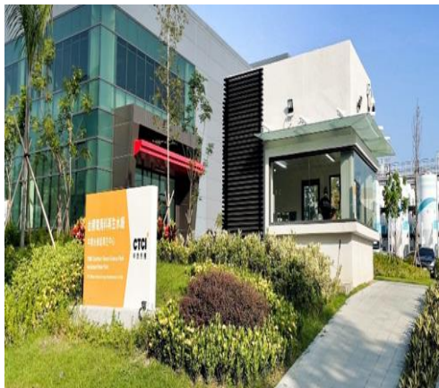
台積電 南科再生水廠
